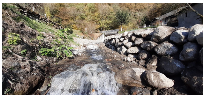
Travaux sur le Nant Brun, à Argentine, à la suite d'une lave torrentielle
