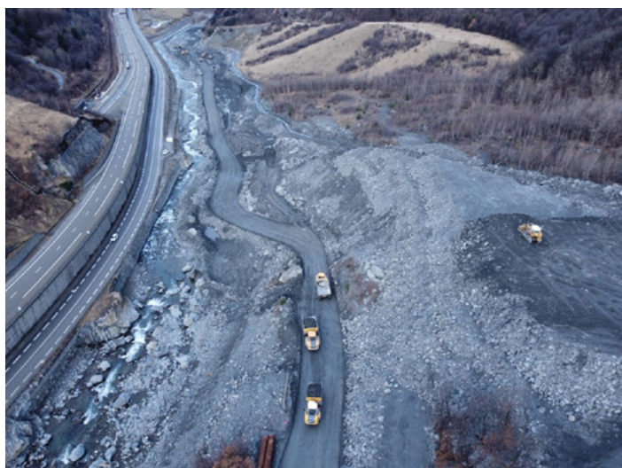
Curage de la confluence Arc-Poucet, à Orelle (Photo : V. Koulinski - ETRM)
