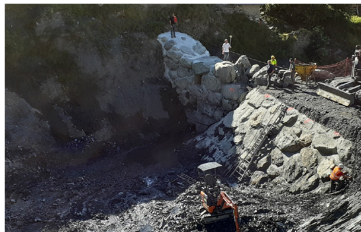
Ouvrage de fermeture de la plage de dépôt du ruisseau de l'Eglise, à St-Sorlin-d'Arves.
