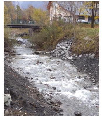
Après les travaux, 8 seuils successifs d'une faible hauteur de chute (© SPM)
