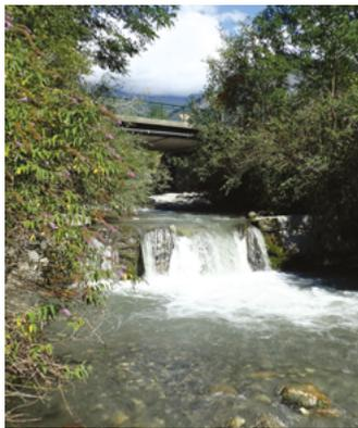
Seuil de la Rizerie avant travaux : un obstacle infranchissable pour les poissons (SPM)
