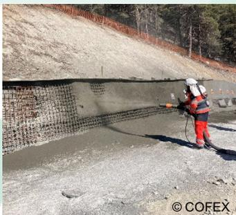
Réalisation du béton projeté de la paroi clouée
