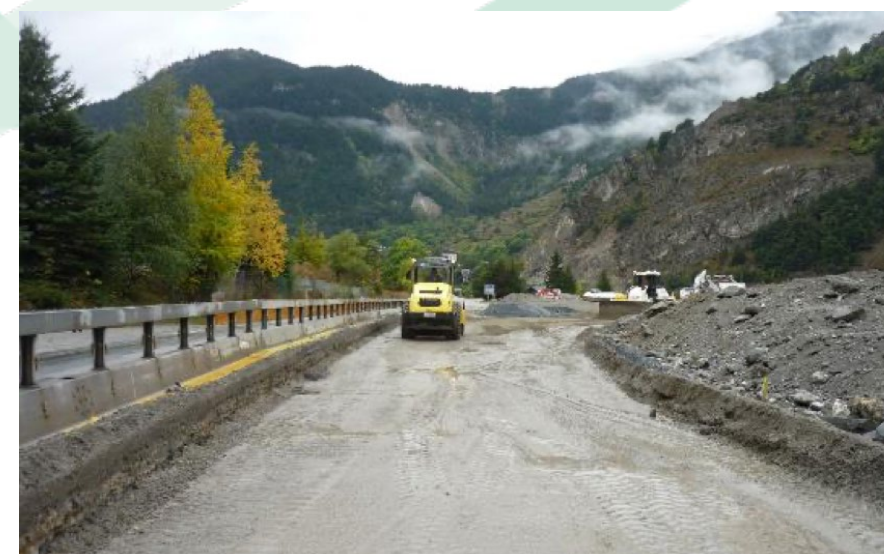
Poursuite des travaux de terrassement
