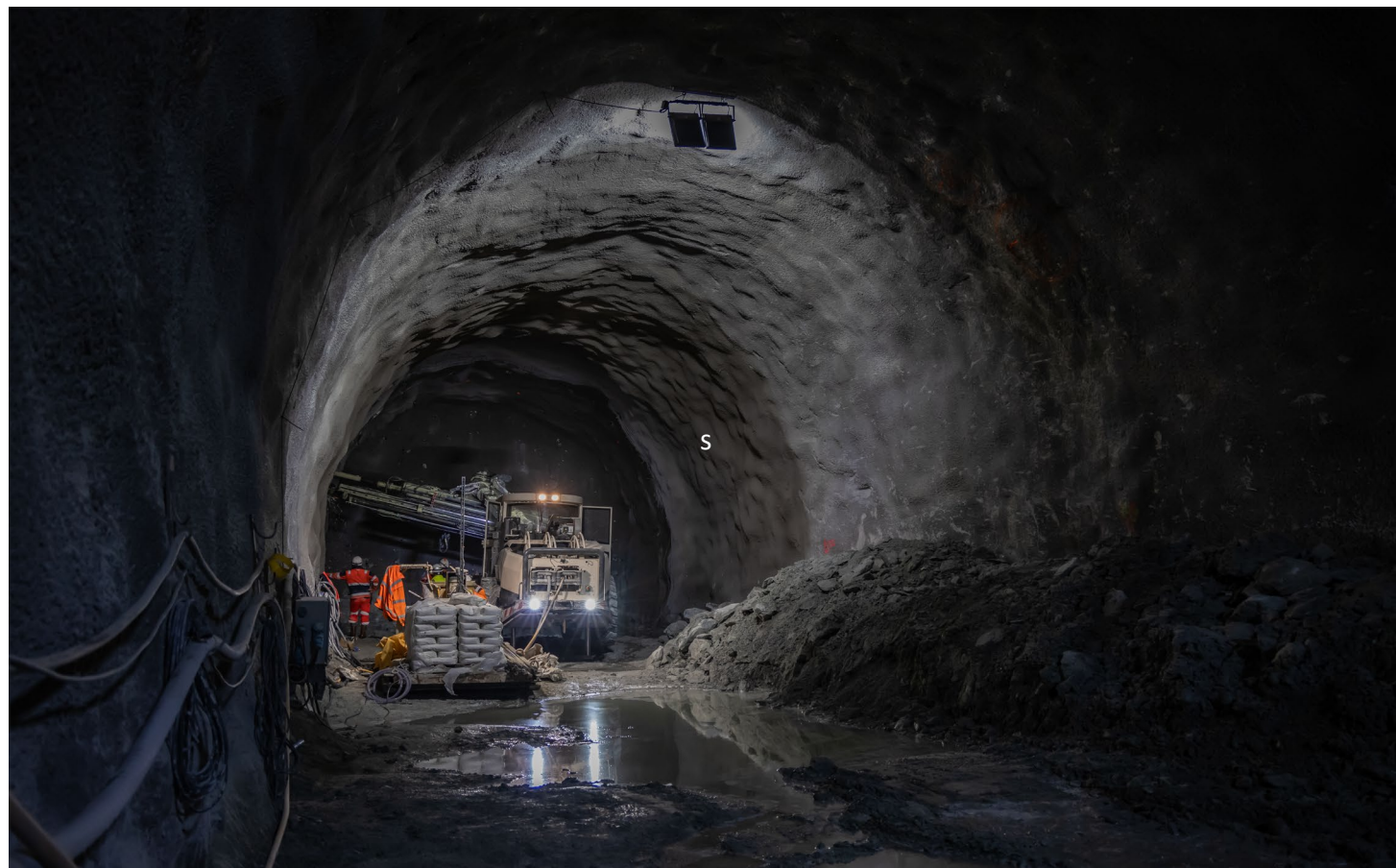
Boulonnage de la voute au niveau du front d'avancement de la galerie de connexion
