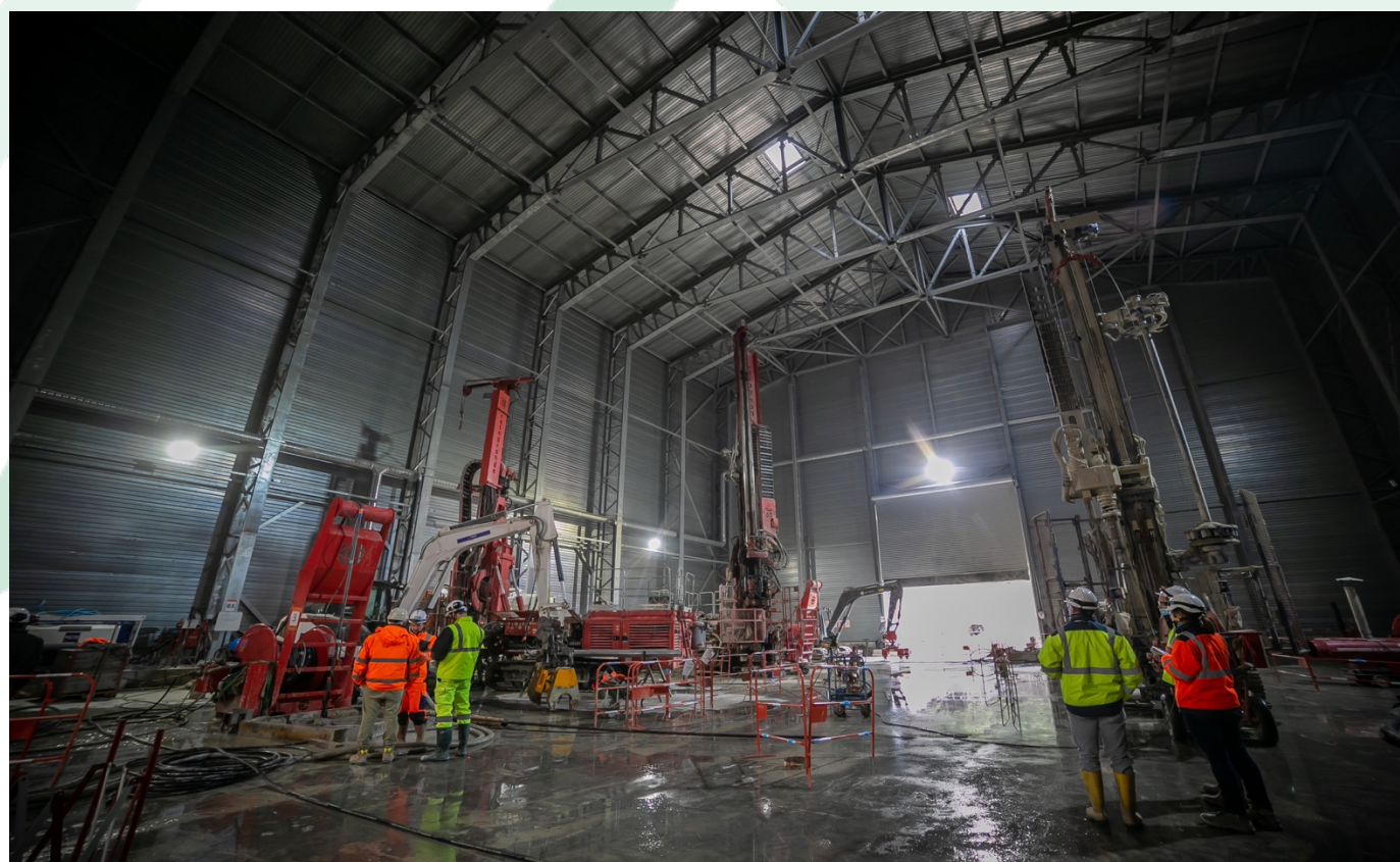
Vue intérieure du hangar acoustique
