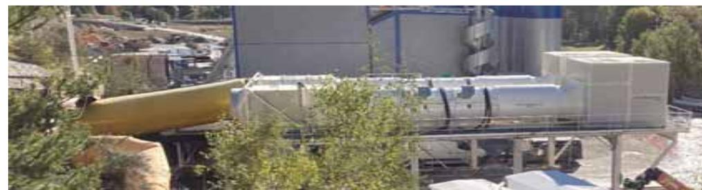
Deux ventilateurs équipés de silencieux et baffles, mis en place sur le portique d'entrée de la descenderie
