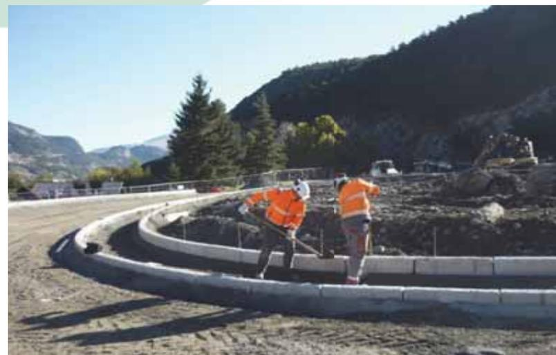
Démarrage des travaux de VRD avec pose des bordures de la phase 1
