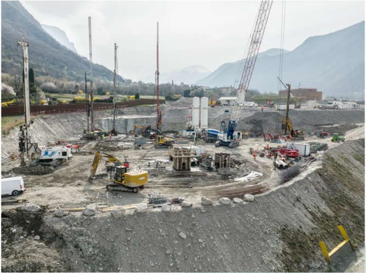
Vue aérienne du chantier
