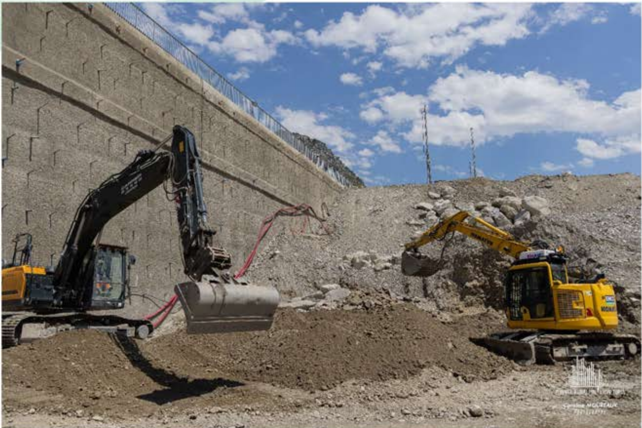
Travaux de terrassements
