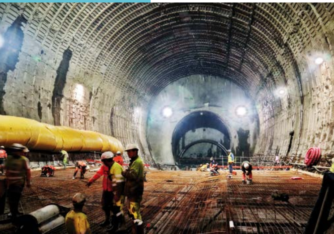
Chantier Lyon-Turin – chambre de montage du tunnelier
