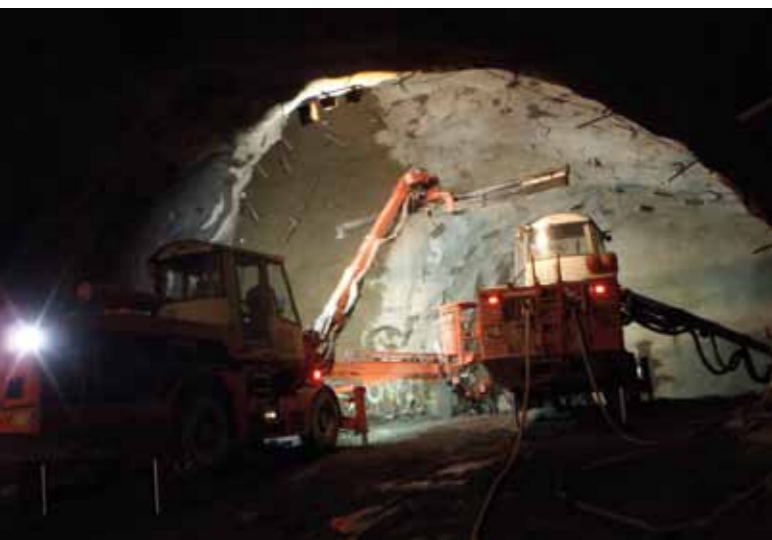
Travaux de la chambre de démontage ▲
