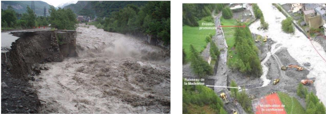
Figure 22 : Photos lors de la crue de 2008, à l'aval de l'usine Ferropem à Montricher-Albanne et au droit de la confluence avec la Madeleine à Lanslebourg (Source : étude ETRM 2017)
