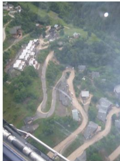
Figure 46 : Débordement du ruisseau de l'Archaz (RTM, 2010)
