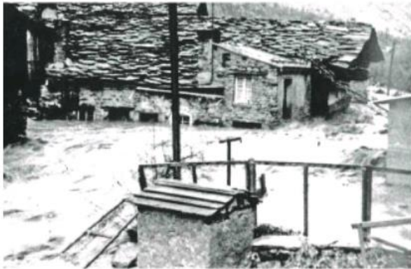
La crue de l'Arc vient lécher les toits des maisons à Bonneval sur Arc
