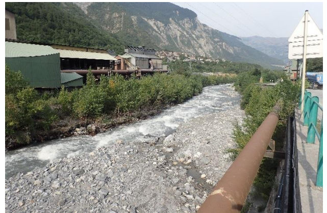
Figure 38 : Réduction de la capacité hydraulique de l'Arc après une lave du Claret (Saint-Julien-Montdenis)
