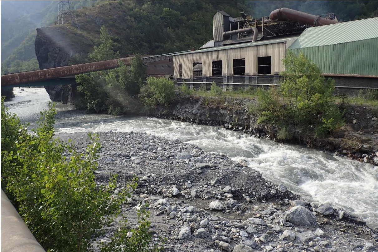
Figure 16 : Dépôts massifs de sédiments provenant du Claret après une lave torrentielle en Août 2019
