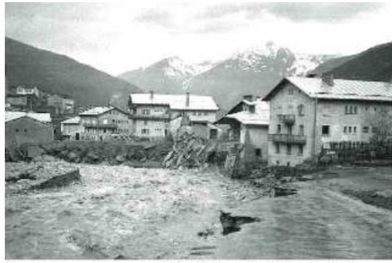
La route est emportée à Lanslevillard ainsi que des bâtiments du quartier de l'Endroit
