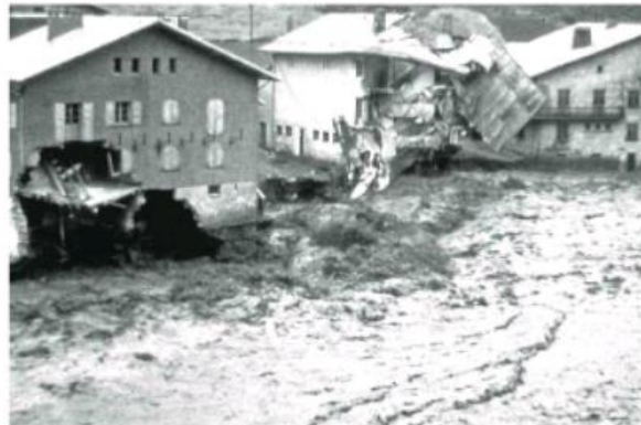
Les maisons en rive gauche de l'Arc, s'effondrent à Bessans
