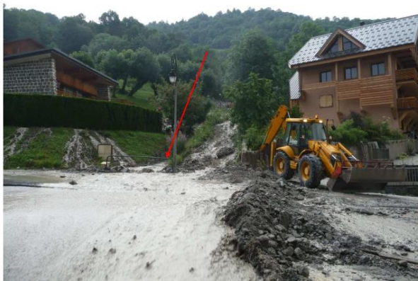
Figure 47 : Débordement du collecteur des Choseaux au droit de la RN902 le 10/07/2020 (RTM, 2010)
