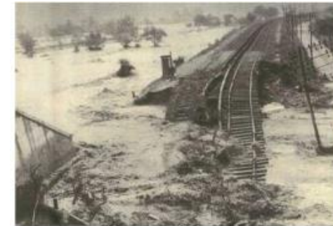
Figure 25 – Destruction de la voie ferrée Chambéry-Modane (crue de juin 1957)
