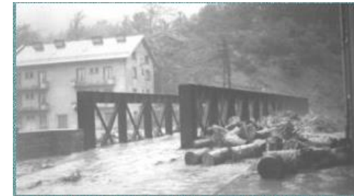
Figure 26 – Troncs d'arbres apportés par l'Arc sur le pont de Modane Gare
