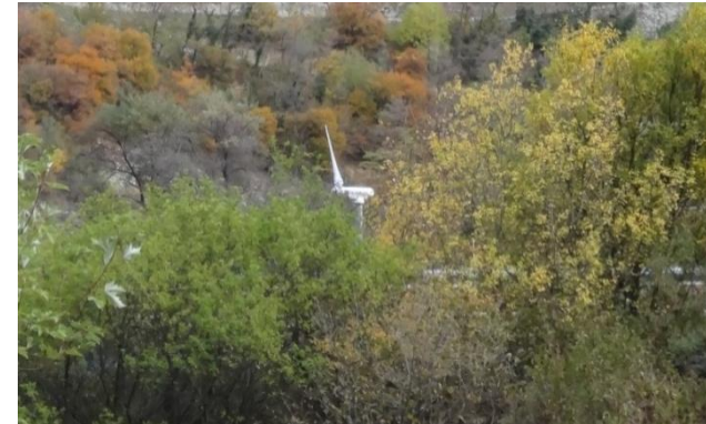
Figure 55 – Eolienne de petite puissance à Pontamafrey-Montpascal Source : Arbor&Sens
